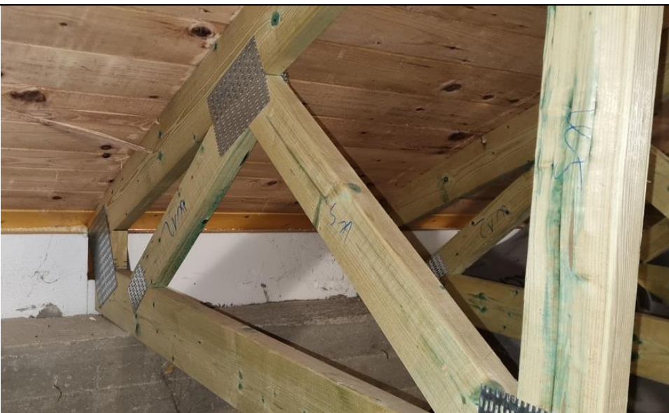
Obr. 5 Uložení vazníků na ŽB průvlaku [P1]
