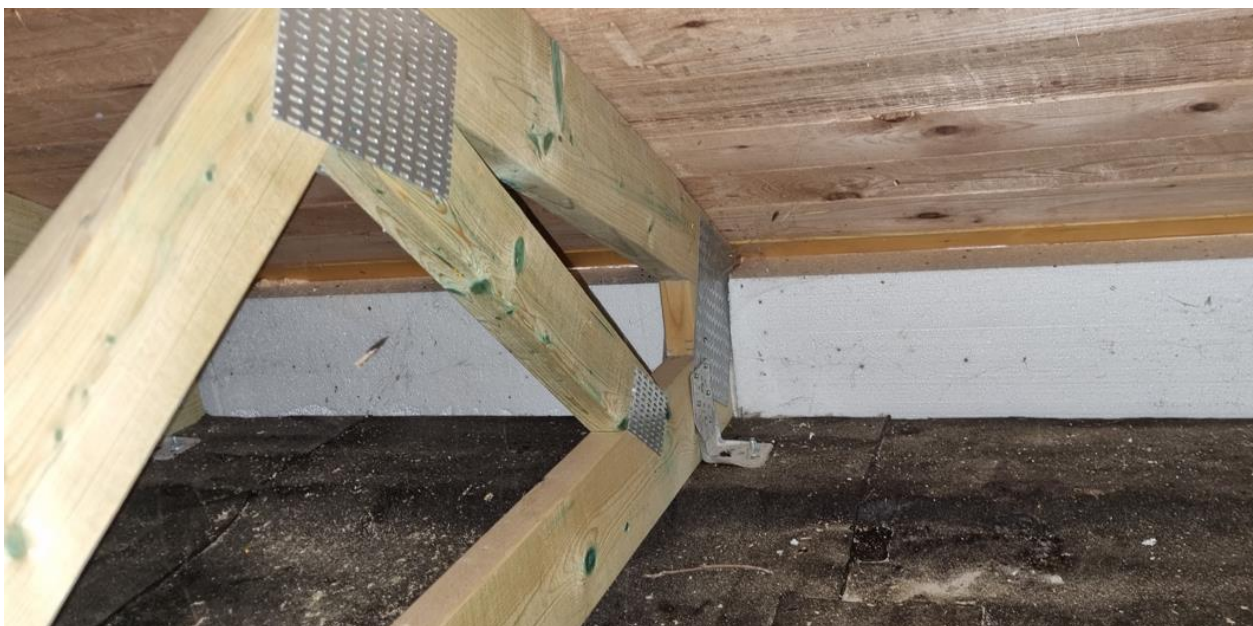
Obr. 6 Uložení vazníků na asfaltový pás [P1]
